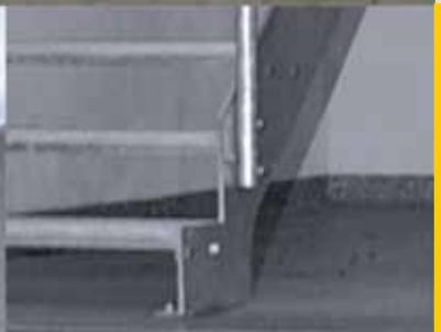
**27** Die verzinkte Wangentreppe verfügt über Gitterroststufen, die mit der Treppenwanne verschraubt sind. Das Geländer können Sie in vielseitigen Varianten erhalten z.B. ein schwarz beschichtetes Pfostengeländer.
