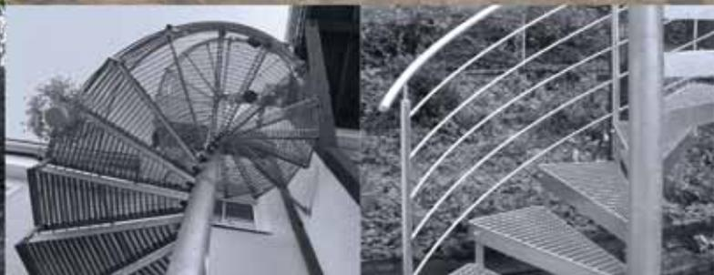
**19** Die verzinkten Gitterroststufen sind am Spindelrohr verschraubt und werden an den Stufenköpfen mittels Laschen verbunden. Das im Bild sichtbare Rohrrahmengeränder dient nur als Beispiel, denn die Außenspindelstiege lässt sich mit vielseitigen Geländertypen kombinieren oder variieren.
