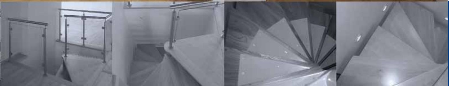
**9** Die auf Grundlage einer Formblechkonsole konstruierte Treppe ist perfekt für schmale Nischen geeignet und kann je nach Raumgestaltung flexibel angepasst werden, z.B. als freistehende Treppe oder als Eckspindeltrappe mit Handlauf an der Wand.
