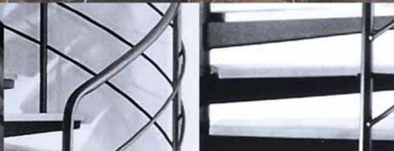
**7** Edelstahlgeländer und Standrohr werden bei diesem Modell mit abgerundeten Massivholzstufen kombiniert, die in verschiedenen Holzarten zur Verfügung stehen. Im Zentrum der Treppe wechseln sich die Stufen mit einer übergeschobenen Edelstahlhülse ab, am Außenrand sind die Stufen mit Edelstahlbolzen verbunden.
