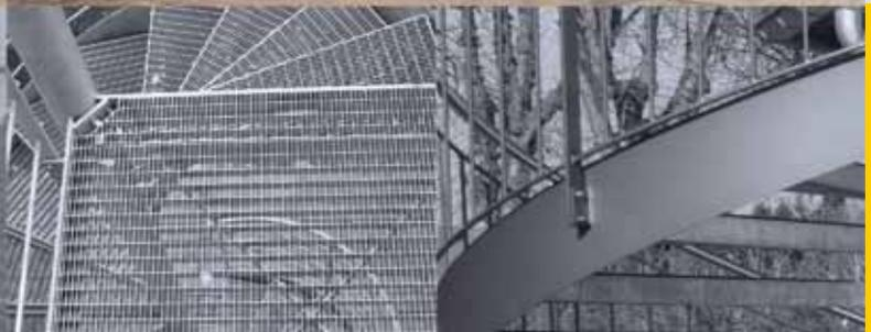
**17** Die verzinkte Spindelstreppe ist als Konstruktion mit und ohne Außenwange erhältlich. Bei den Stufen sind verschiedene Ausführungen möglich, wie auch das oben abgebildete Pfosten-Rahmengeländer was nur eines von vielen Geländerbeispielen ist.
