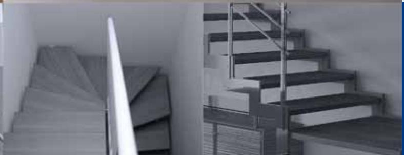
**11** Bei dieser Wangentreppe sind die Holzstufen zwischen den Wangen auf angeschweißte Lochlaschen geschraubt. Ihnen stehen nicht nur mehrere Geländermöglichkeiten zur Auswahl, Sie können auch eine hochgezogene Treppenwange mit Lichtöffnungen fertigen lassen.
