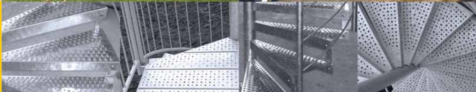
**23** Um größtmögliche Stabilität zu gewährleisten, sind die trapezförmigen Stufen der Spindeltreppe an der Spindelsäule verschraubt sowie an der Außenseite mit Laschen versteift. Gelochte Stufen sorgen wiederum für eine optimale Rutschhemmung.
