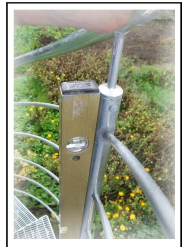
Geländer mit Wasserwaage genau Ausrichten.
