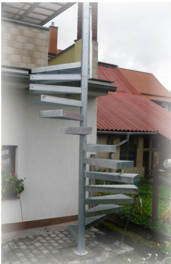
**Schrauben Sie die Stufen mit der beiliegenden Hutmutter M16 an die Rohrsäule.**
