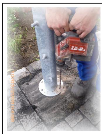
Verankern Sie die Fußplatte mit geeigneten Schwerlastankern entsprechend dem Verankerungsgrund.
