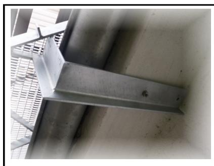
Verankern Sie das Podest mit geeigneten Schwerlastankern entsprechend dem Verankerungsgrund.
